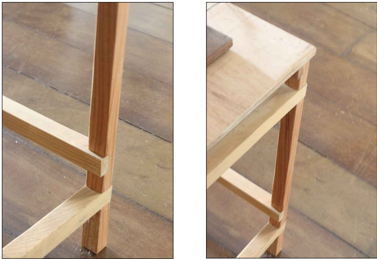
fotos com detalhe de encaixe dos pés da mesa.
