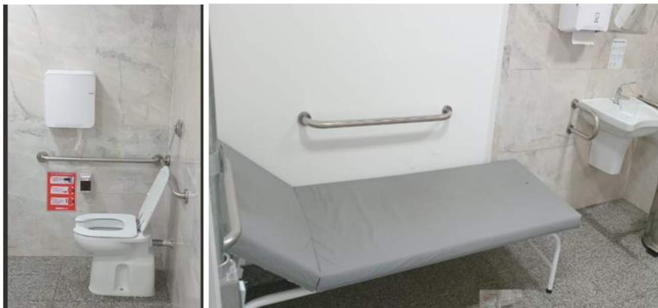
Banheiro PCD. Foto equipe de facilities.
